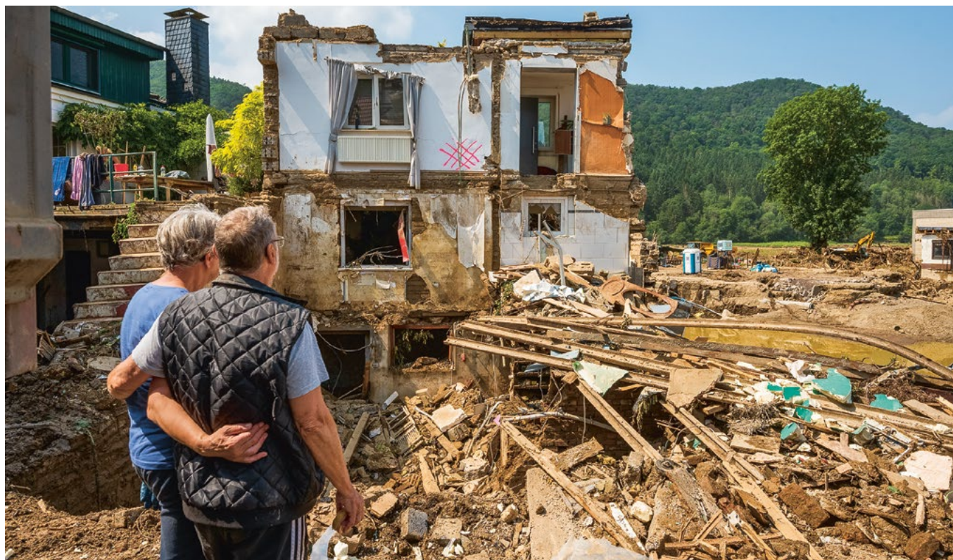
▲ Eine Woche danach. Vor den Trümmern in Rech im Ahrtal.
